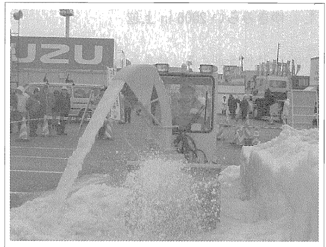
写真二 会場の広さの制約から小型除雪機械による実演が行われた
