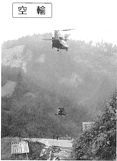
写真-8 ヘリコプターによる重機等の輸送
