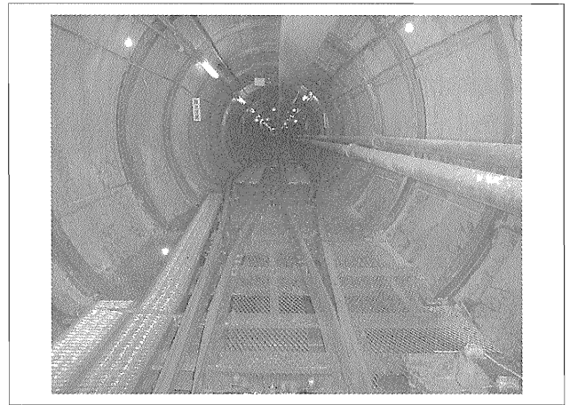
写真-6 坑内の離合部 (浜ノ瀬幹線)
