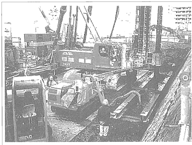
写真—2 ジェコソイルシステム施工状況
