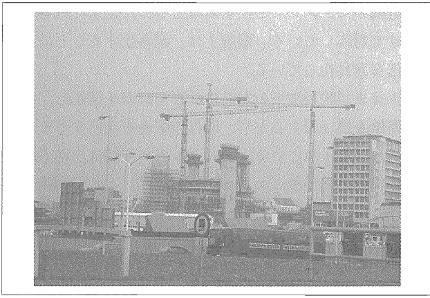
写真-33 トンボクレーンを使用した施工
