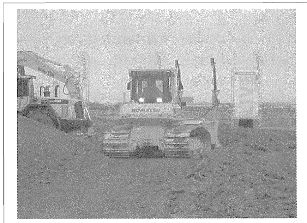
写真-24 マシンコントロールシステムのデモ
