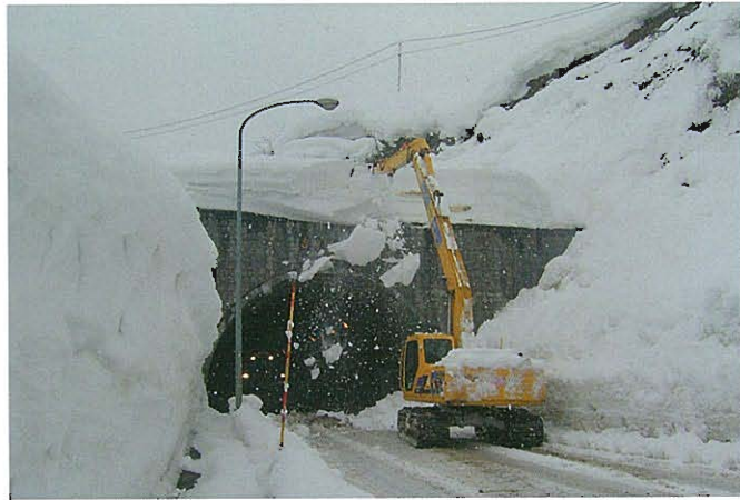
⇩ロングリーチバックホーによるトンネル入口雪庇落とし作業
