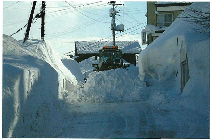
↑集落内通行止めにしてタイヤドーザによる除雪作業
