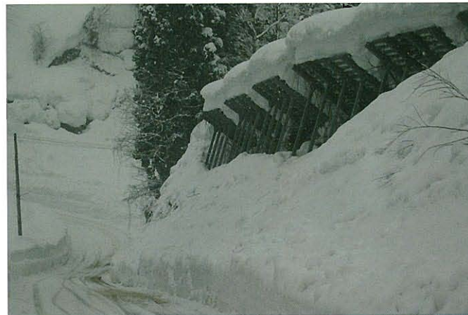
⇩県道法面の除雪作業前の状況
