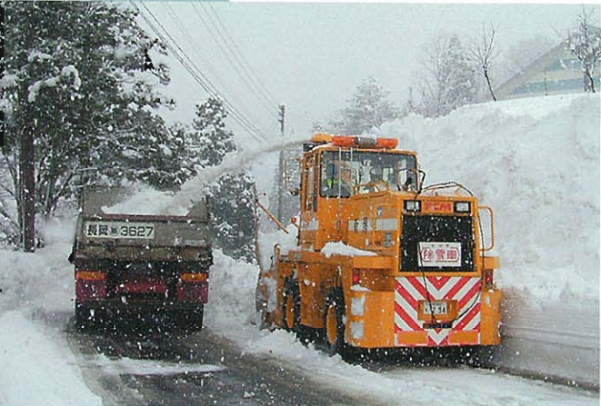
↑幅員拡幅作業およびダンプ排雪
