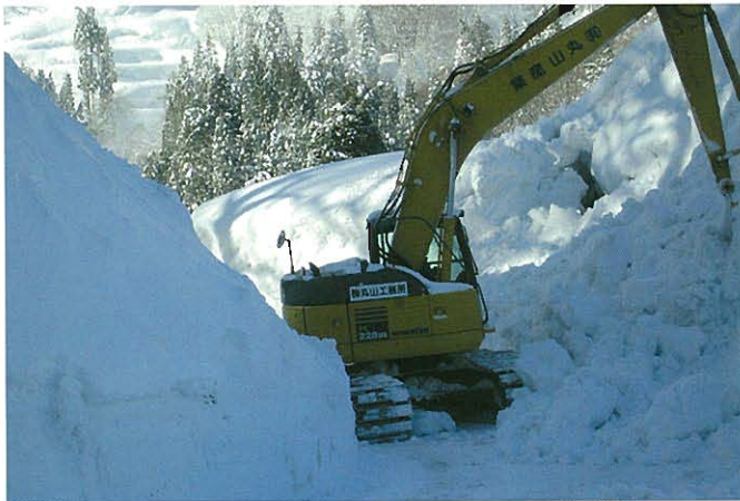
⇩バックホーによる雪庇落とし後の排雪作業
