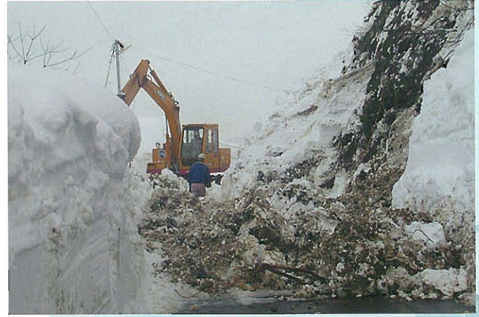
⇩雪崩により通行止めとなり排雪作業
