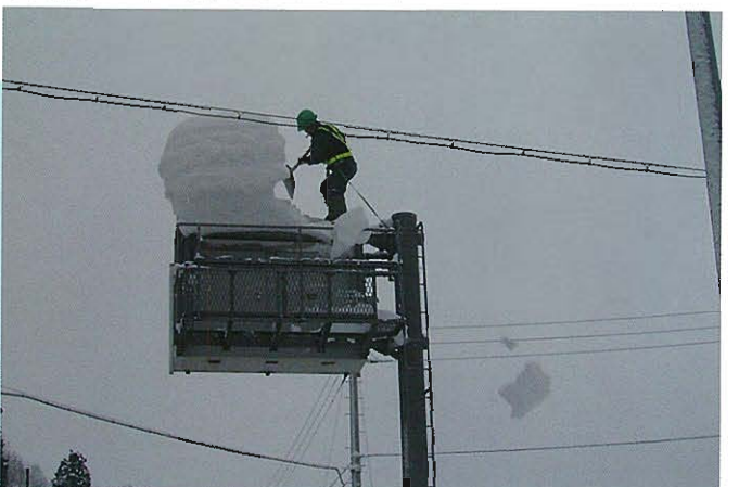
↑国道道路標識の人力による雪下ろし作業
