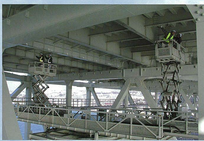
⇩明石海峡大橋:橋梁点検補修作業車(桁内面作業車)による点検
