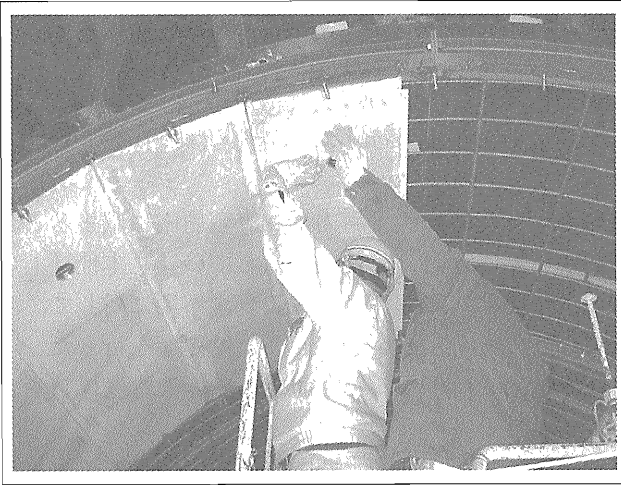
写真—1 覆工板の取付け状況
