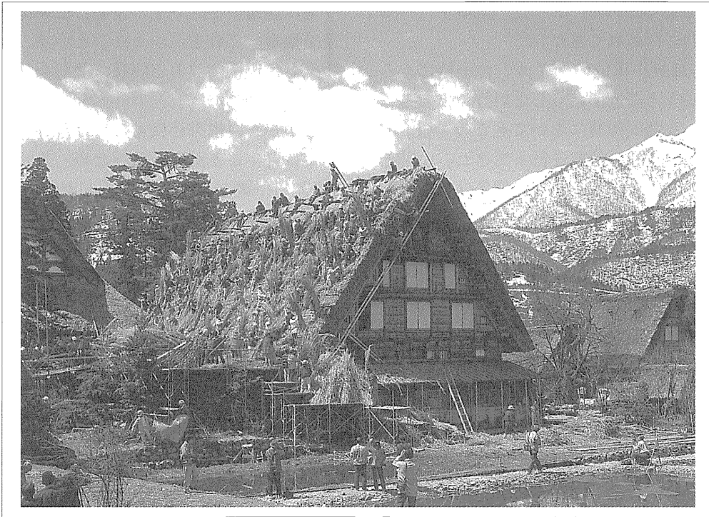
写真一2 「結」による屋根葺きの様子
