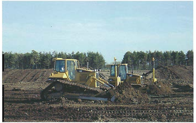
⇩ 圃場整備における整地均平作業
