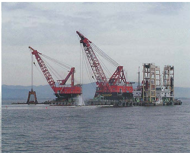
⇨ケーソンの撤去作業
