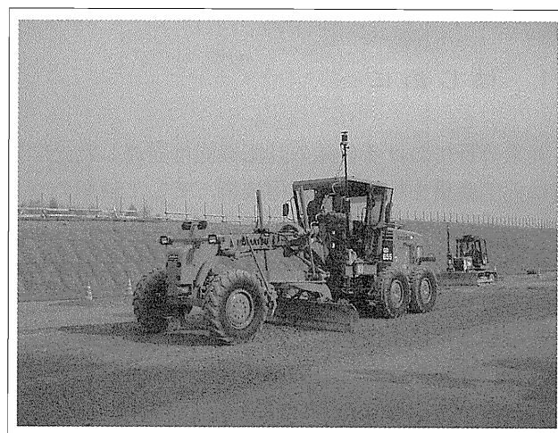
写真-1 mmGPS-3 D-MC グレーダ稼働現場
