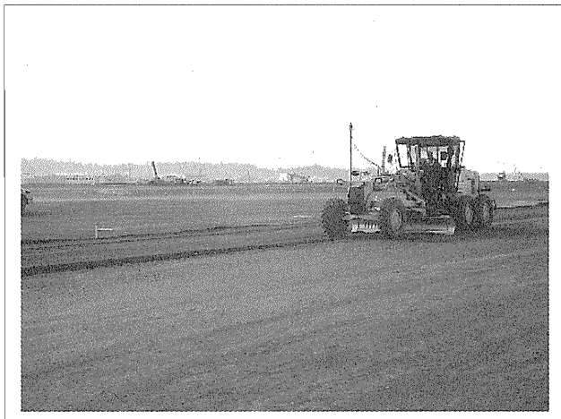
写真-3 mmGPS-MC モータグレーダ施工状況
