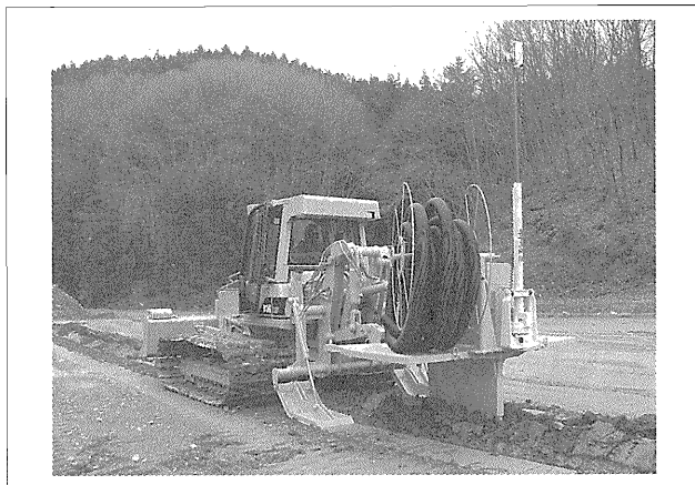
写真—3 ベスト・ドレーン暗渠工法 D3G
