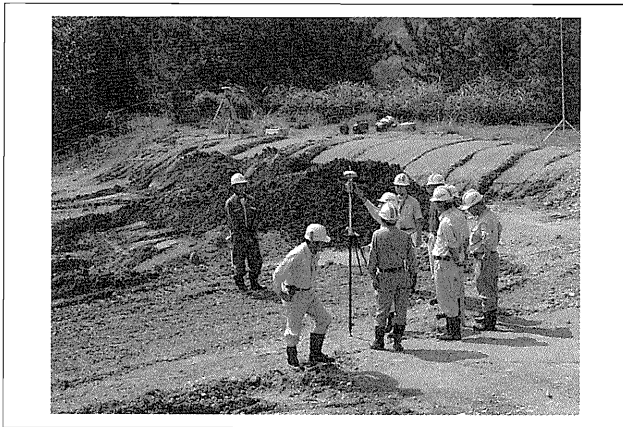
写真—9 ミリメータ GPS による高さ検測
