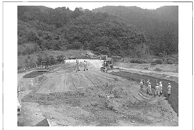
写真—2 入力した数値制御データを利用した実体験施工状況
