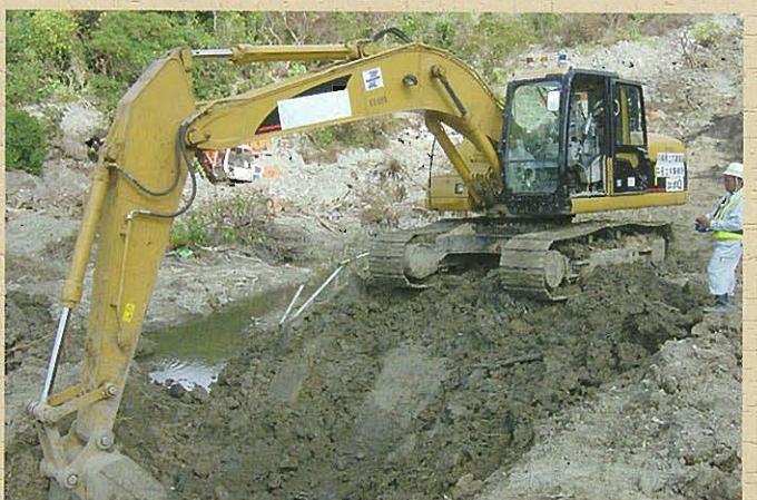
↑現地施工状況
