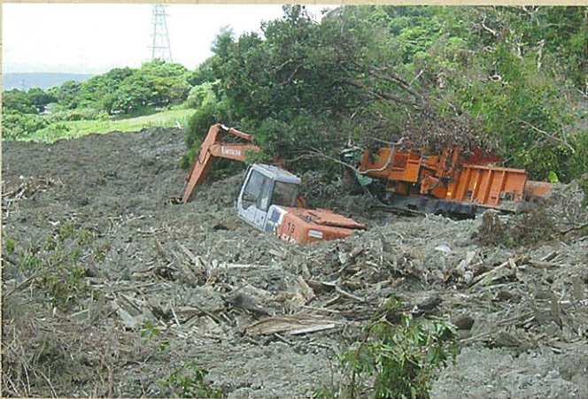
↑現地被災状況
