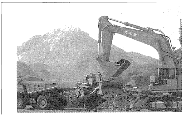
写真一1 除石工施工状況
