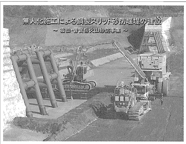
写真-3 スリットダム施工状況
