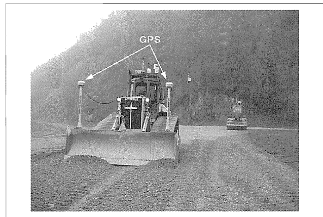
写真一6 敷均し状況
