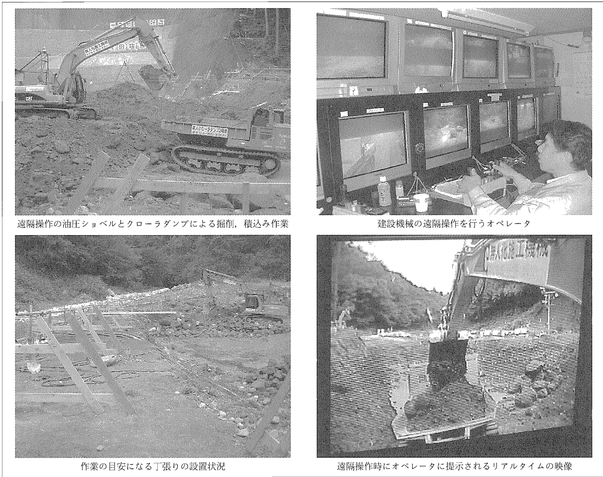
図-4 現状の遠隔操作による掘削、積込み、運搬作業の例
