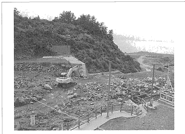
写真—6 施工現場全景
