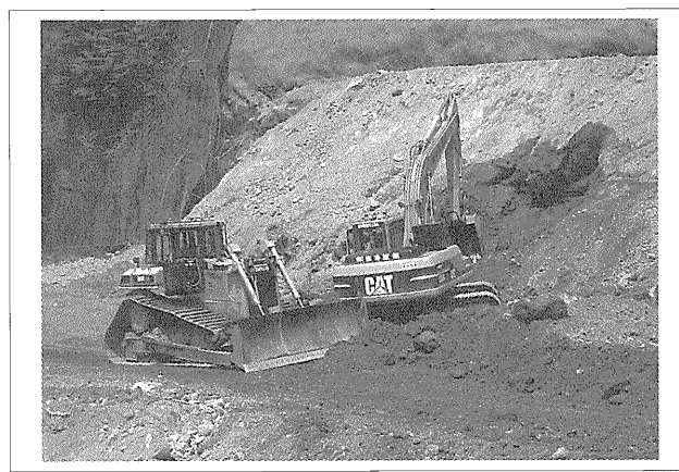
写真—9 施工状況
