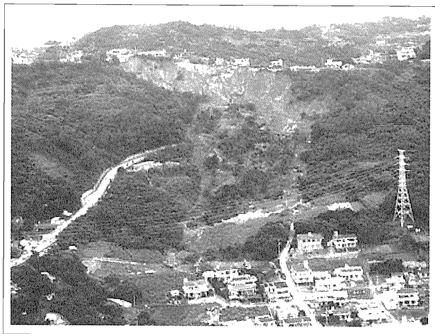
写真—10 現地被災状況（写真提供：沖縄総合事務局）
