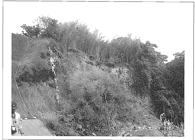
写真-4 現地被災状況
