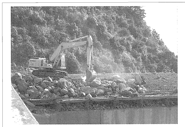
写真—7 施工状況
