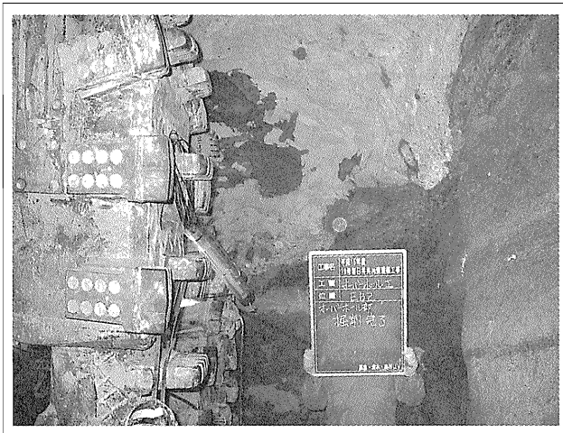
写真-5 切羽オーバホール作業空間
