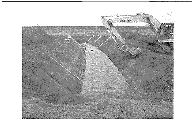
写真-1 丁張りレスのバックホウ作業
