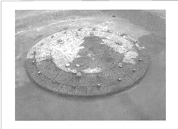
写真—3 杭頭処理後
