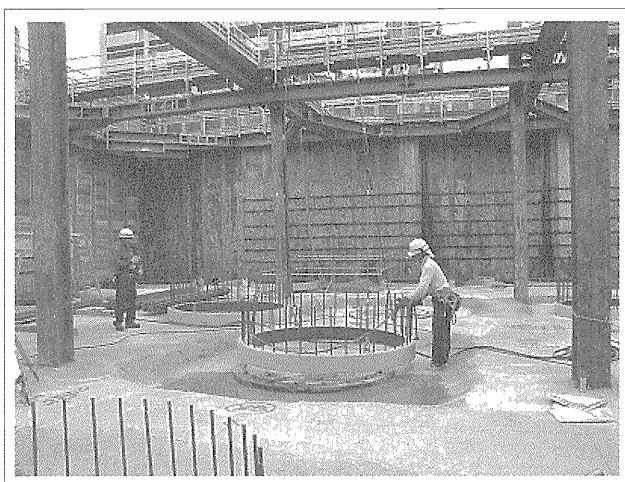
写真—5 PCリングの設置
