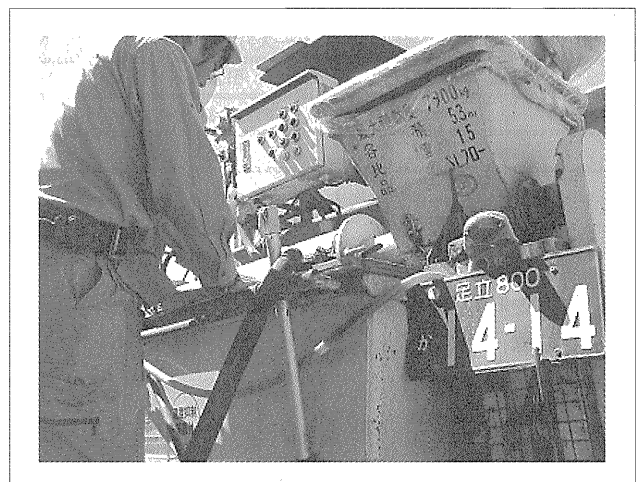
写真—8 ローリ車によるモルタル圧送
