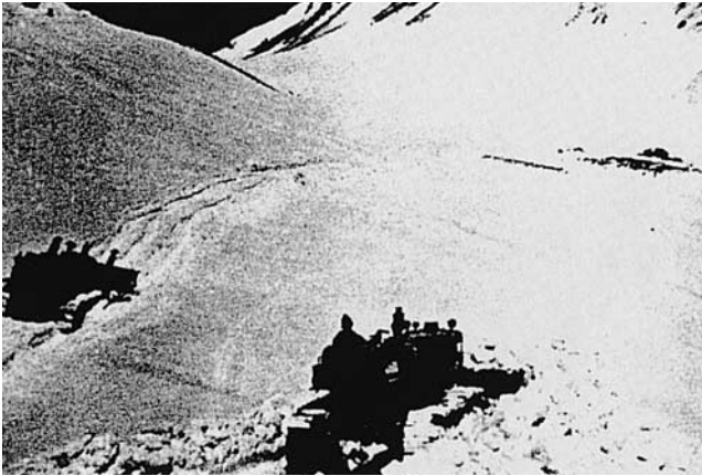
写真一12 ブルドーザのアルプス越え 昭和32年の春先、残雪を利用して重機械を自走させ、アルプス越えを敢行する快挙をなし遂げた。
