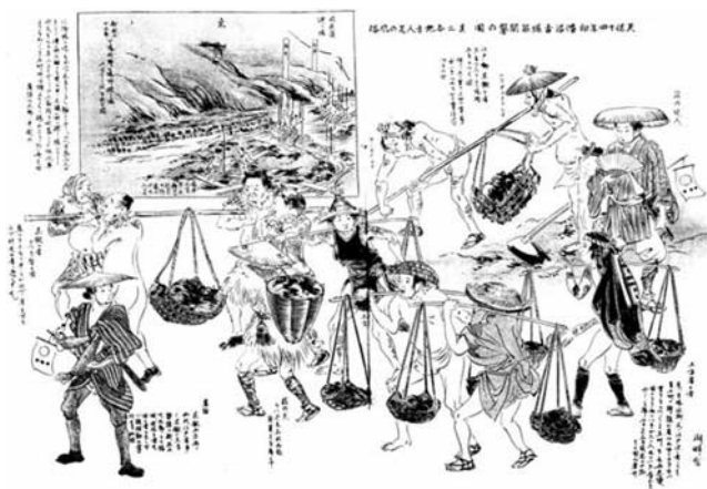
図一 印旛沼の開鑿工事の風景
