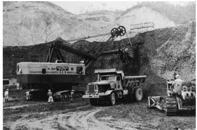
写真—9 遮水壁材採取現場
