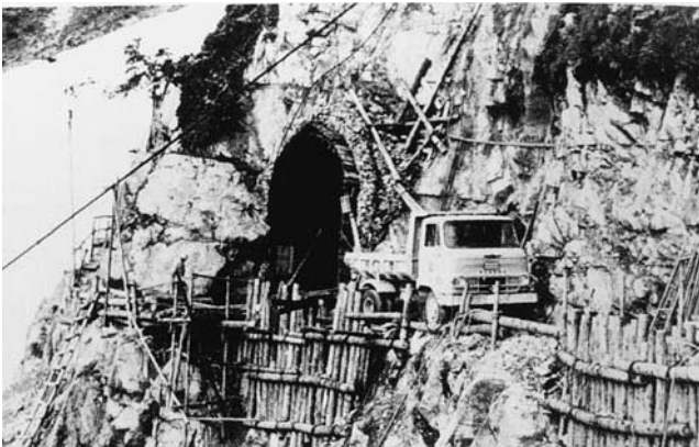
写真一13 立山トンネルの横坑 黒部側延長1578m。工事は標高2315mの断崖の横坑掘削から始まる。ズリ運搬のダンプは、絶壁に設けた道路をバックで横坑に入る恐怖の連続である。
