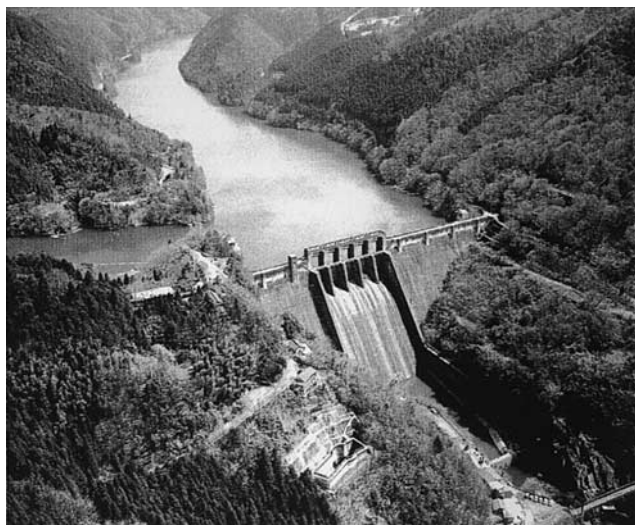
写真-5 丸山ダム
