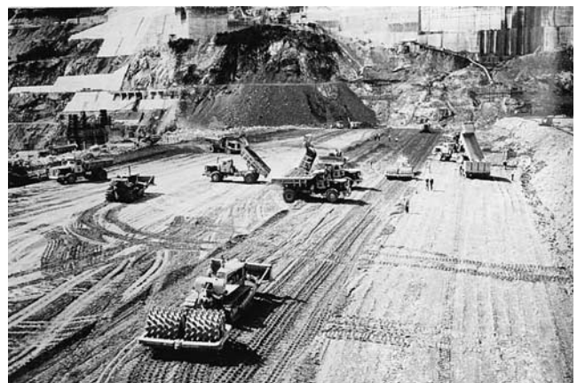
写真—10 土質遮水壁の締固め
