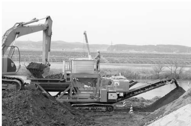
図一七 築堤工事で活躍する土質改良機 SR-G2000
