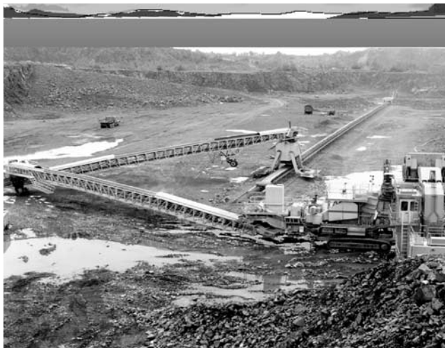
図一六 碎石現場で活躍するロコリンクシステム
