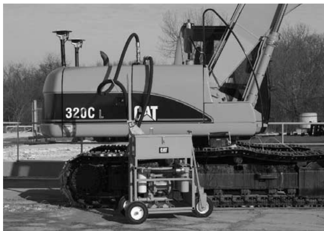
写真—9 オイルフラッシング
