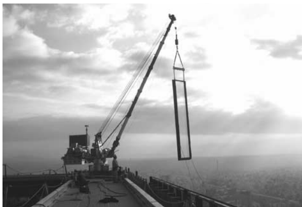
写真—9 タワークレーン解体機による外装施工
