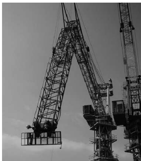
写真一 4 ブームの自力折り畳み状況
