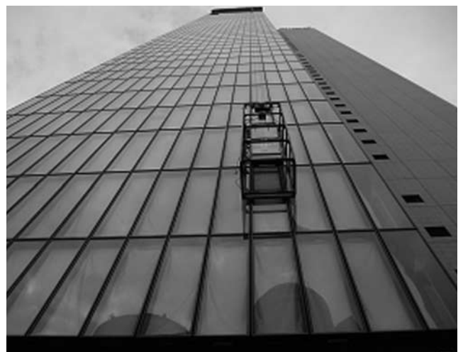
写真-8 耐風揚重フレームによる外装揚重
