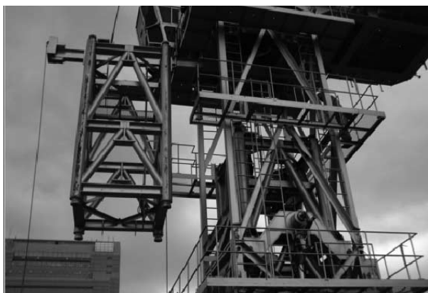
写真一 3 マスト吊り込み状況
