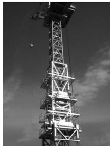
写真-1 OTA-150Hのクライミング装置
