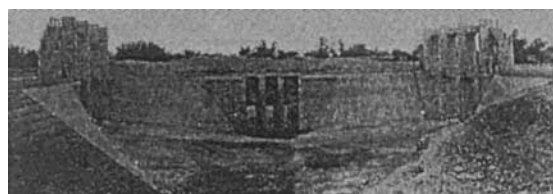
写真—9 導水路を流れてきた水が南幹線と北幹線に分かれる工事中的分水門（古川勝三著「台湾を愛した日本人」より転載）
