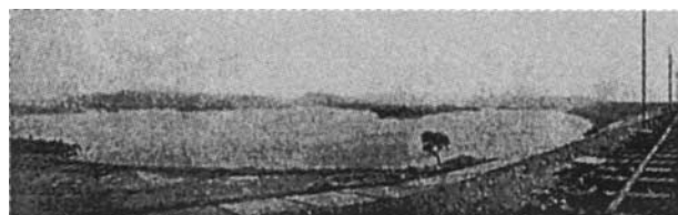
写真—8 満水になった珊瑚潭貯水池。まだ工事用レールが敷かれたままになっている。（古川勝三著「台湾を愛した日本人」より転載）
