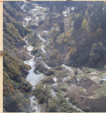
↑大規模な地滑りにより寸断された R291 (神沢川沿い)
