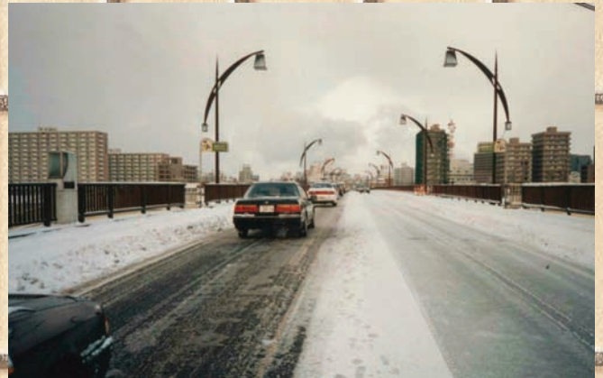
⇩凍結抑制舗装（左側，すべり抑制）
