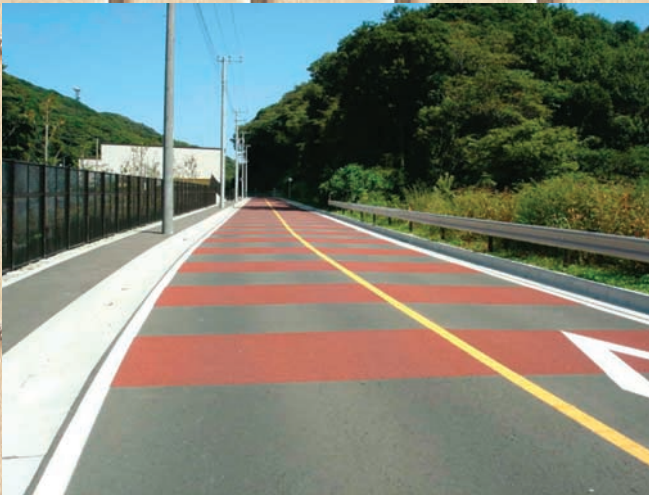
⇩樹脂舗装（すべり抑制・視認型注意喚起）
