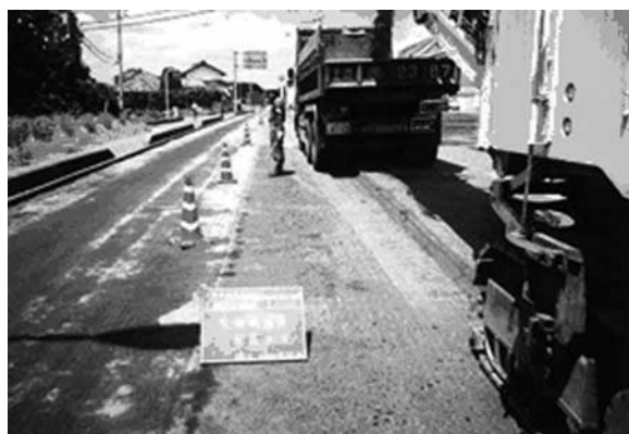
写真一 2 切削工法
