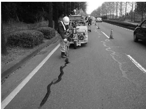
写真一 1 シール材注入工法
