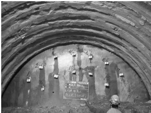
写真一五 長尺鏡補強工
