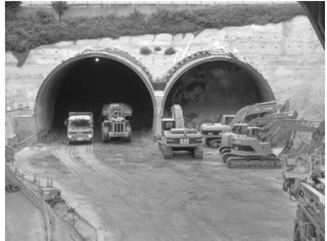
写真一四 坑口部施工状況
