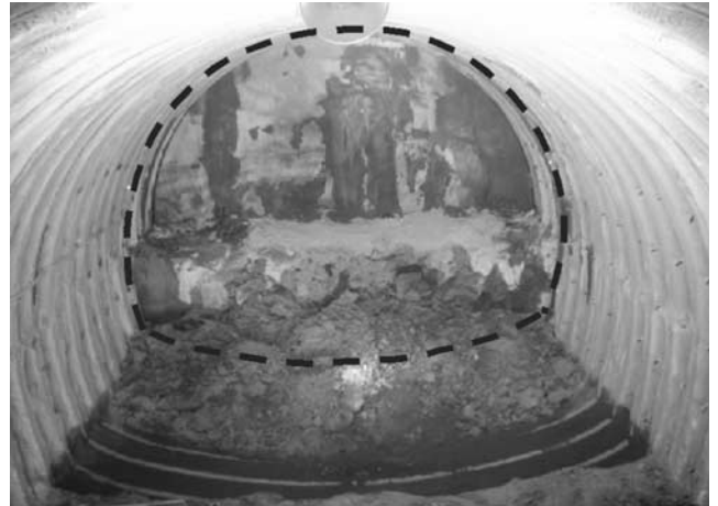
写真一七 全断面の早期閉合状況
