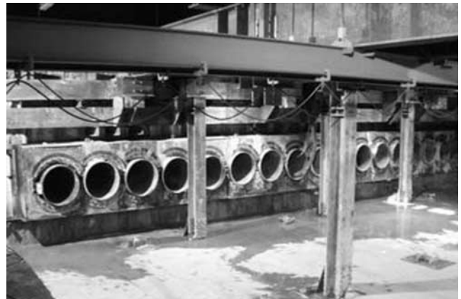
写真-5 水平部パイプーフ全景
