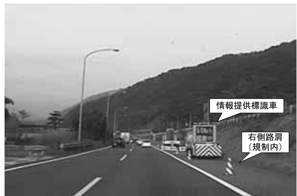
写真一2 リバース運用区間 走行状況
