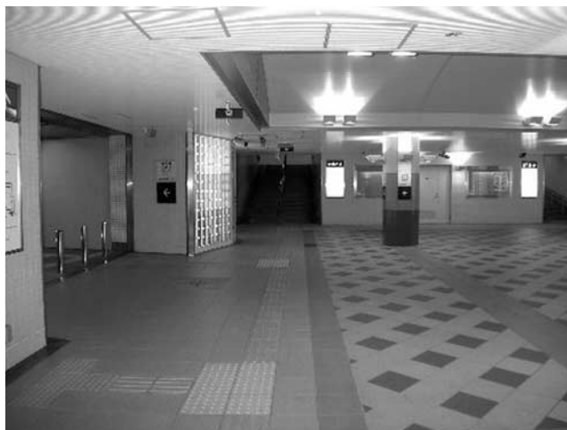
写真一四 京都府 国道1号東野地下連絡通路
