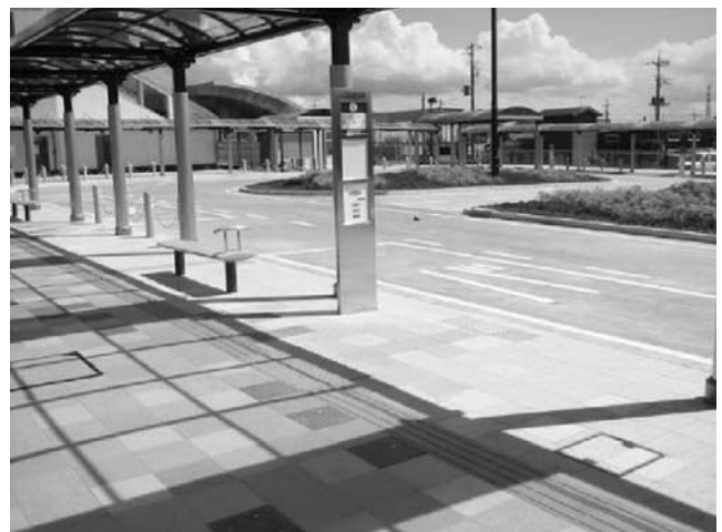
写真-2 静岡県 JR 長泉なめり駅前
