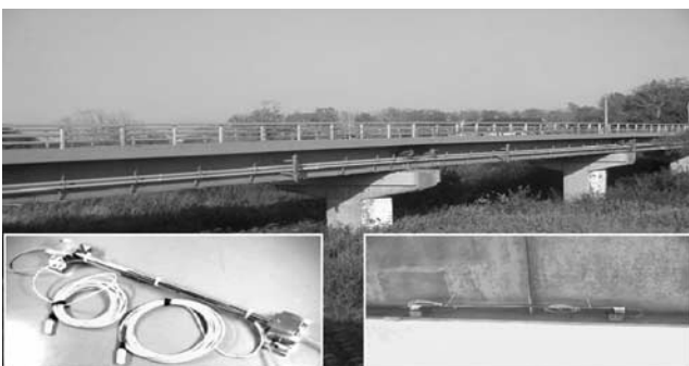
写真四 クラック監視中の道路橋
