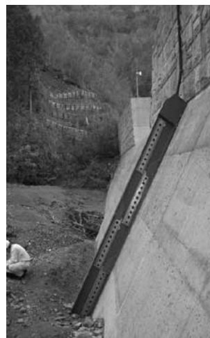
写真一十 堆砂センサ設置状況
