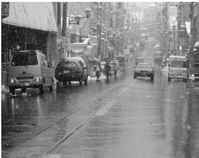
写真一1 下水再生水を利用した消雪パイプ (新潟県湯沢町)
