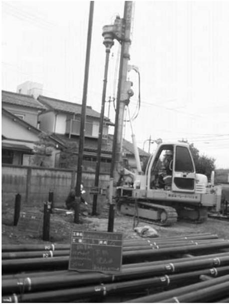
写真一五 戸建て住宅用杭打設機による熱交換杭の設置
