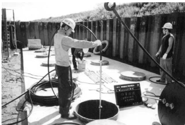
写真—3 ポリエチレン管の杭への挿入
