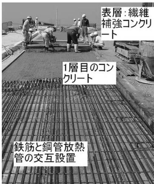
写真—4 連続鉄筋コンクリート舗装で乾燥収縮目地をなくし、曲げなしの直線放熱管の施工
