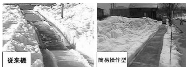
写真—7 除雪後の残雪状況
