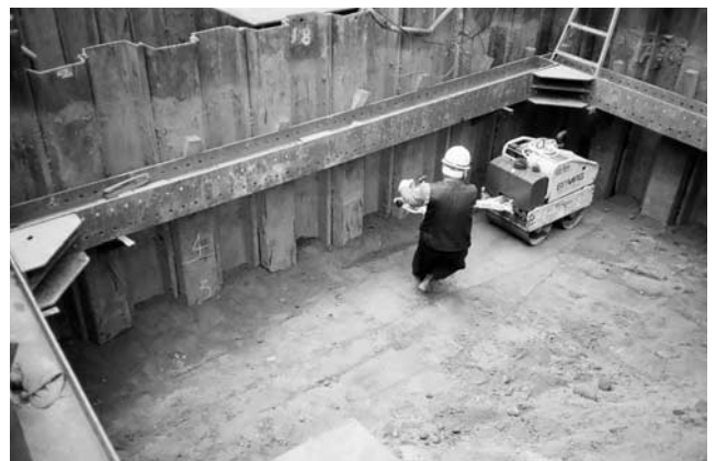
写真一1 清浄土埋戻し(転圧)
