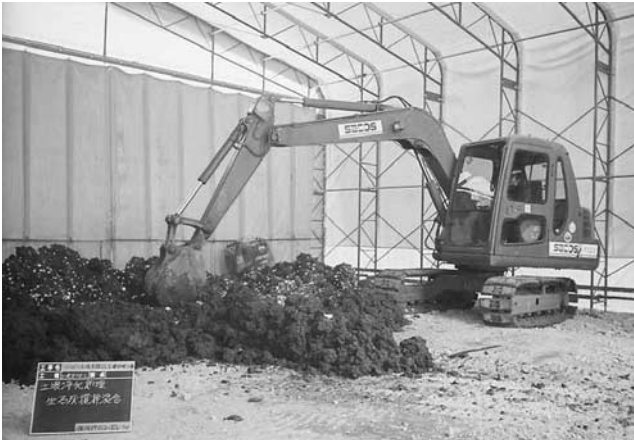
写真—3 生石灰混合（テント内）
