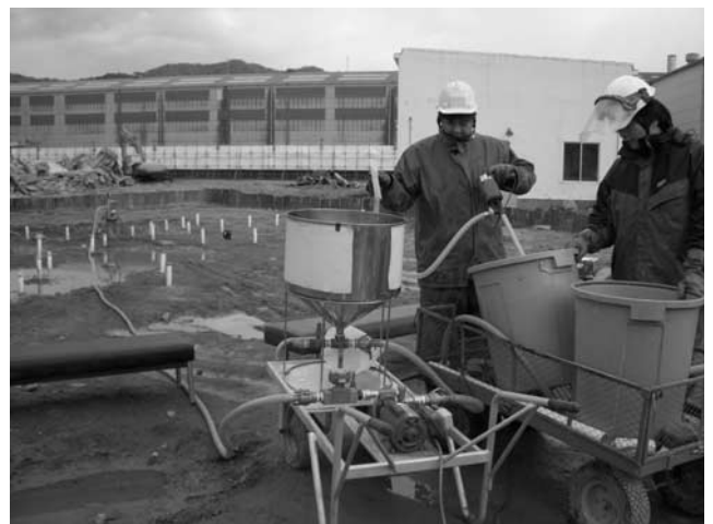
写真—6 酸化剤の注入状況
