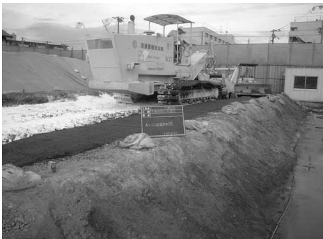
写真一4 スタビライザーによる資材混合状況
