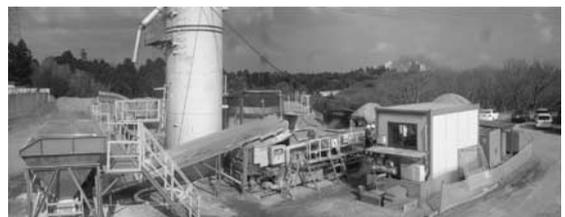
写真—2 定置型フォームドアスファルトプラント(操作室側から望む)
