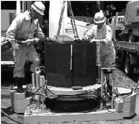
写真三 油圧機・ケーシング設置工
