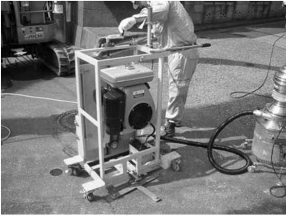
写真一 円形カッターによる舗装版切断工
