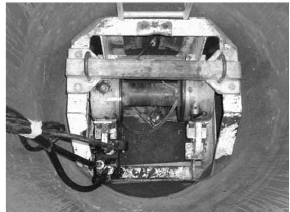
写真六 既存管路更新（引抜き工法）
