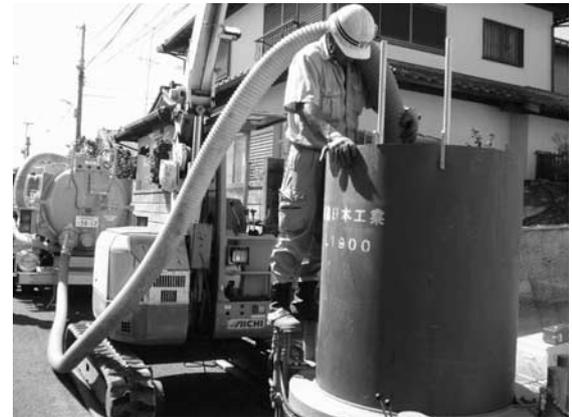
写真四 吸引掘削工
