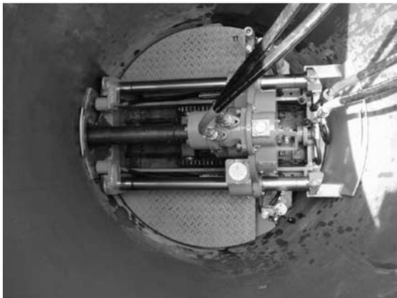
写真五 新設管路敷設（推進工法）
