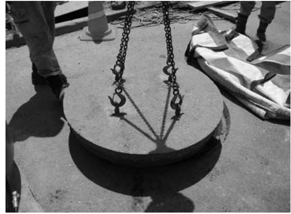
写真二 掘削舗装版処理工
