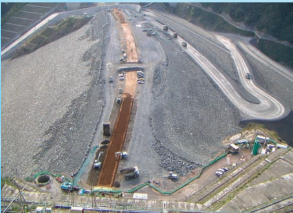
⇩ 堤頂部の盛立施工状況
