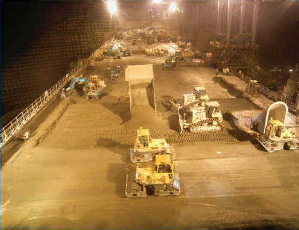
⇩ 中標高部のRCD工法施工状況(全平面を3分割, 打込厚 1.0 m)
