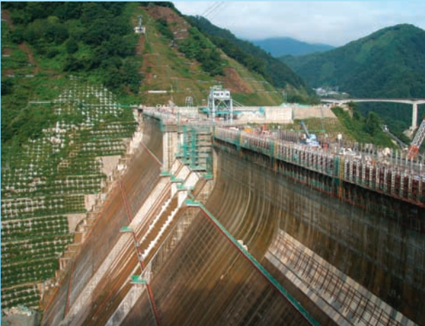
⇩ 打設完了間近の堤頂部施工状況
