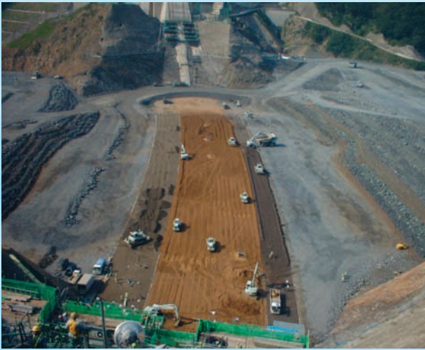
⇩ 中標高部の盛立施工状況
