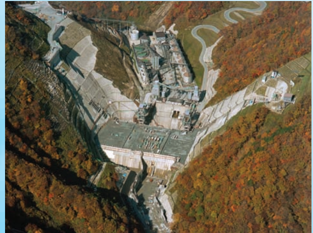
⇩ 堤体と上流の施工機械設備状況
