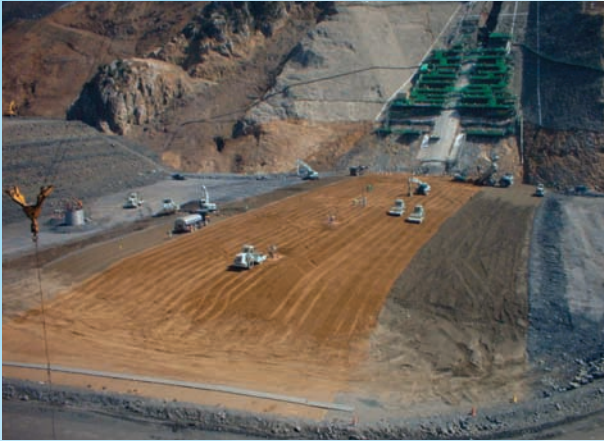
⇩ 低標高部の盛立施工状況
