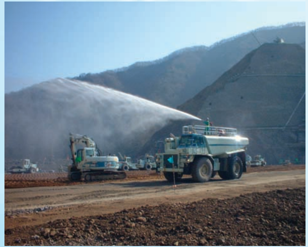
⇩ コア盛立面の散水状況 (CAT773 改造車)
