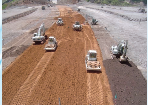
⇩ コア材の転圧施工状況
