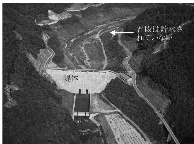
写真—29 河床穴あきダム，益田川ダム
