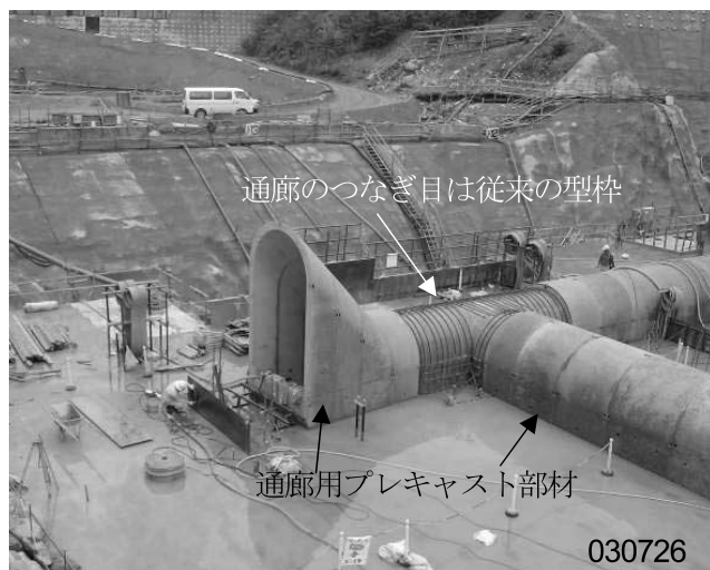
写真-14 プレキャスト通廊, 木戸ダム
