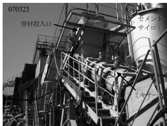
写真-15 スパイラル式CSGミキサー, 稲葉ダム
