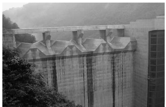
写真一25 ラビリンズ型越流頂の上流側、苦田ダム
