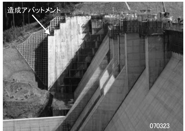
写真一 3 傾斜型造成アバットメント、稲葉ダム
