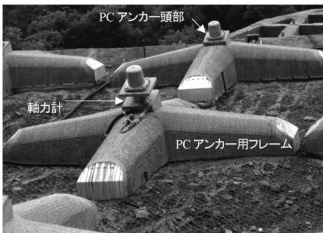
写真—7 PC アンカー工，奥胎内ダム
