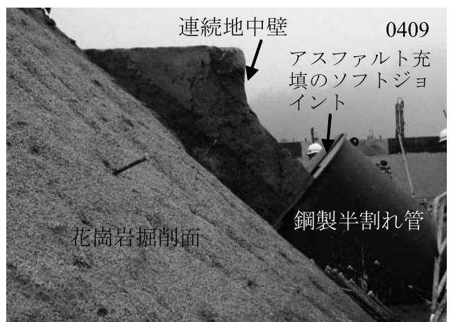
写真一 4 連続地中壁、小山ダム
