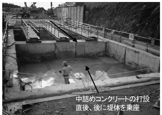
写真一 5 箱型連続地中壁、岩井川ダム右岸
