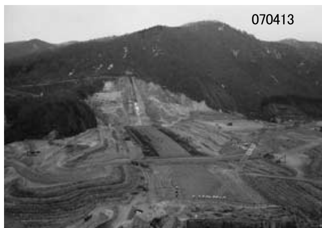
写真—22 情報化施工による盛立, 胆沢ダム
