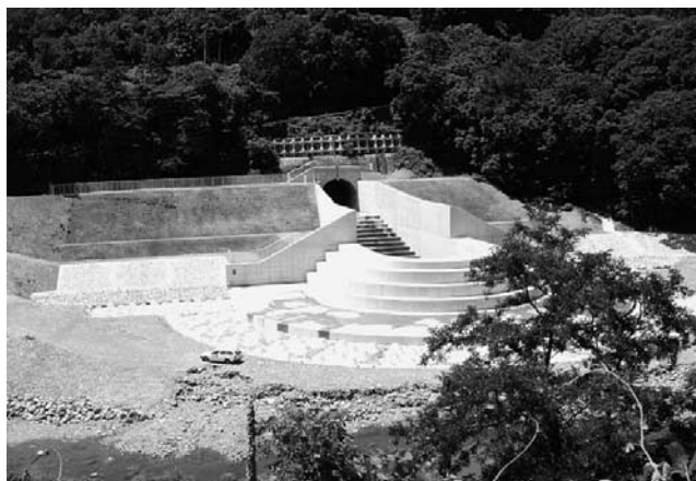
写真—28 排砂バイパス吐き出し部，美和ダム
