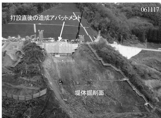
写真一 2 標準型造成アバットメント、北河内ダム
