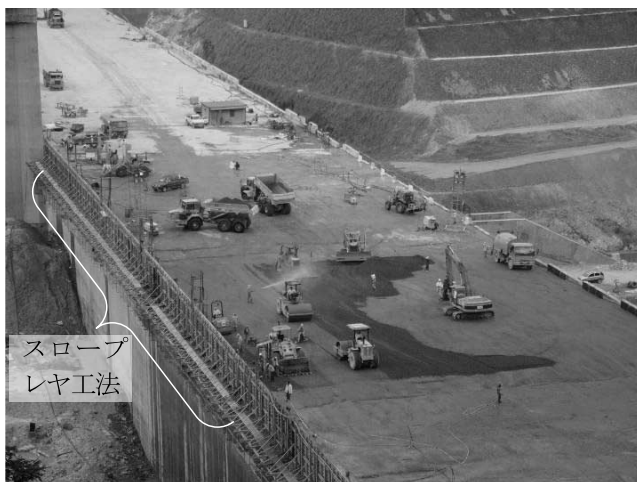
写真—9 RCC工法，スンガイキンタダム
