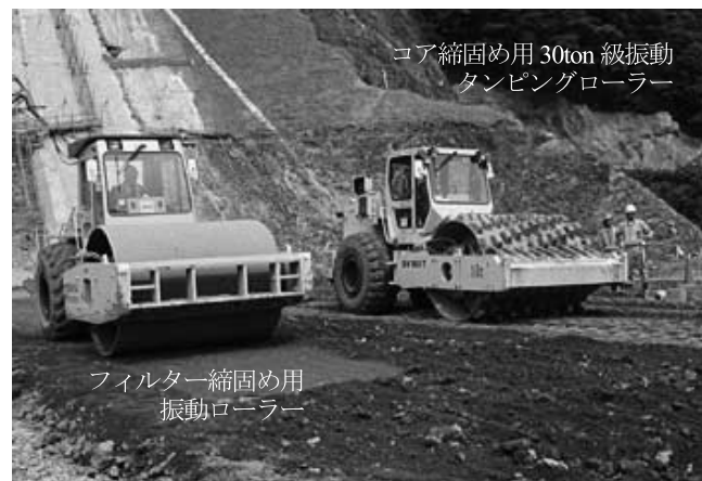
写真-18 締固め用振動ローラー、徳山ダム
