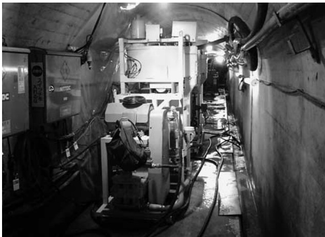
写真一 1 リムトンネル内ユニット設置状況
