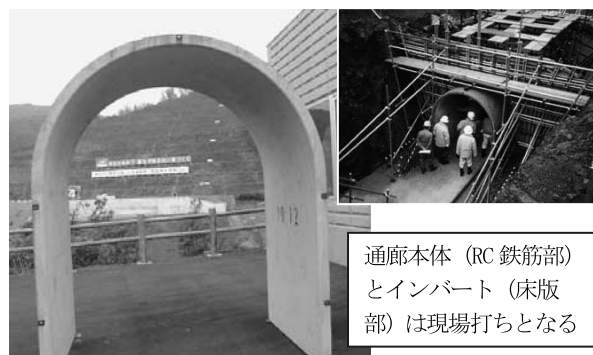
写真一二十 通廊用プレキャスト型枠、榎谷ダム
