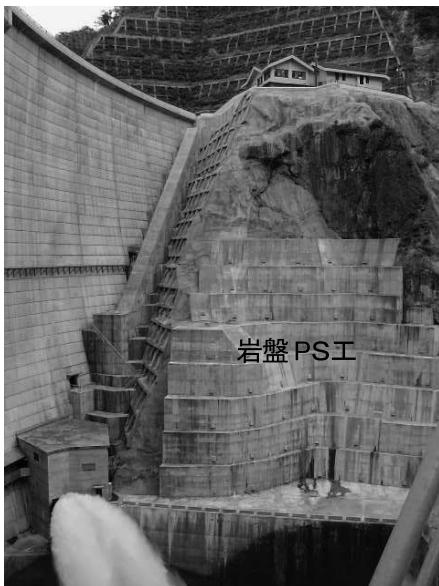
写真—6 岩盤PS工，奥三面ダム
