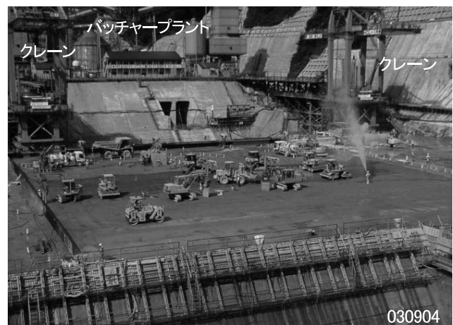
写真—8 連続RCD工法による打設，長井ダム
