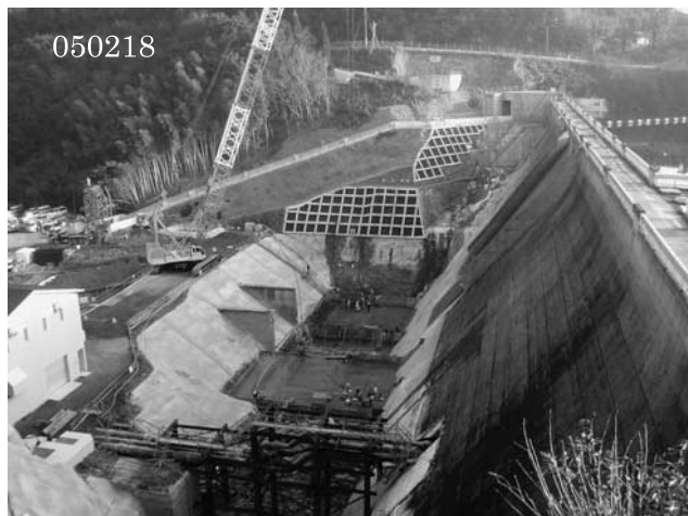
写真一26 堤体嵩上げ高5.9m, 下の原ダム
