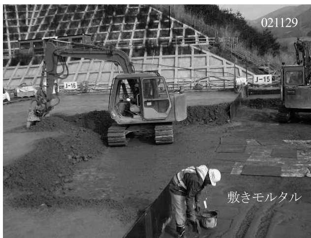
写真—10 拡張レヤ工法，鷹生ダム
