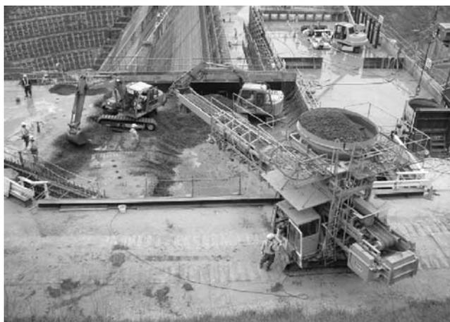
写真—6 スプレッダコンベヤによる打設状況
