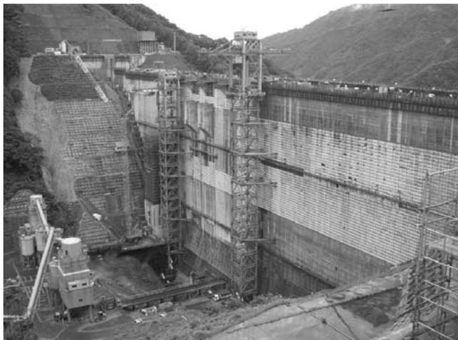
写真—1 堤体高標高部の打設状況
