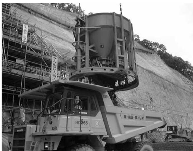
写真—4 自重蓄圧開閉方式 9 m<sup>3</sup> 油圧バケット
