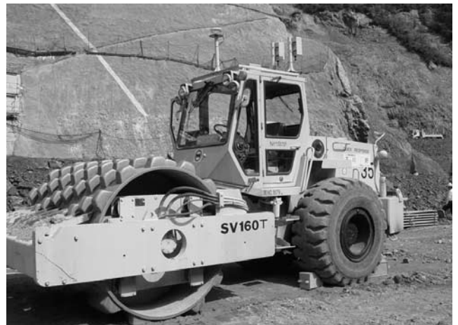
写真一 10 GPS アンテナが設置された転圧機
