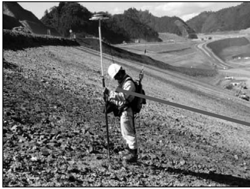
図-7 三次元ワンマン測量システム
