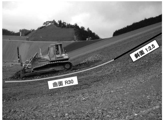
写真-2 TSブルドーザ
