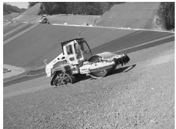
写真一 3 締固め管理システム搭載の斜面用ローラ
