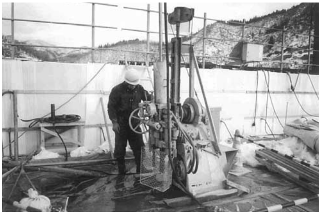
写真—1 ロータリーボーリングマシン
