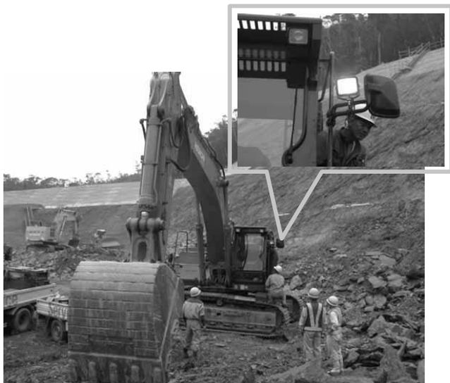
写真—4 重機安全ライト設置状況
