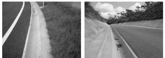
写真-1 小動物保護型側溝
