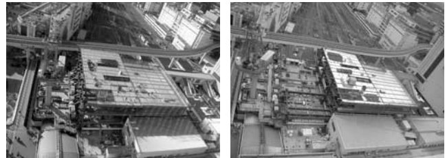
写真-1 スライド実施状況
