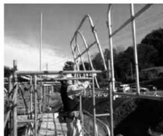
手すり設置作業
