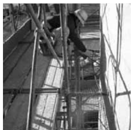
安全ネット設置作業
