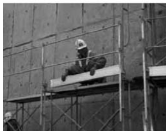
幅木(つま先板)設置作業
