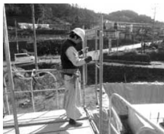
枠組み設置作業
