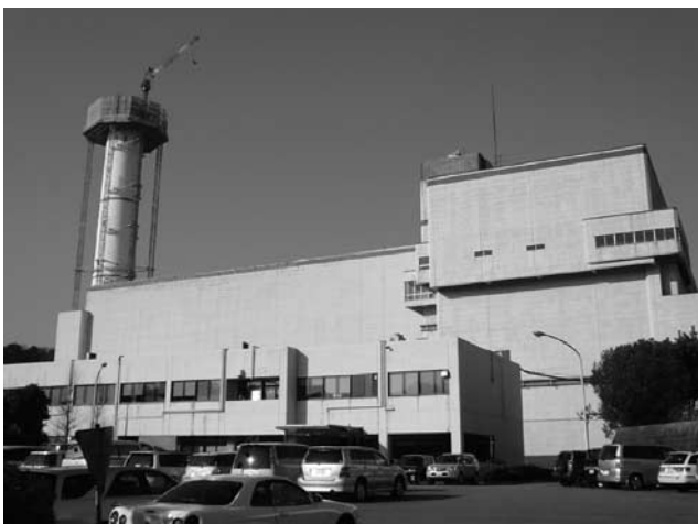
写真—1 S 焼却施設の解体工事状況
